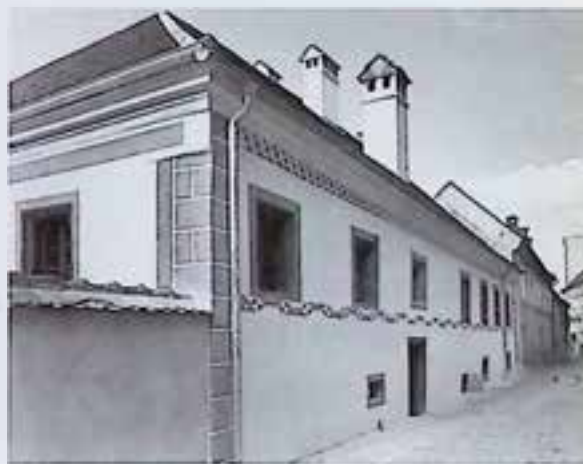
Steyr, Fabrikstraße 7, nach Freilegung und Restaurierung der Renaissancefassade. Foto: W. Ebenhofer
