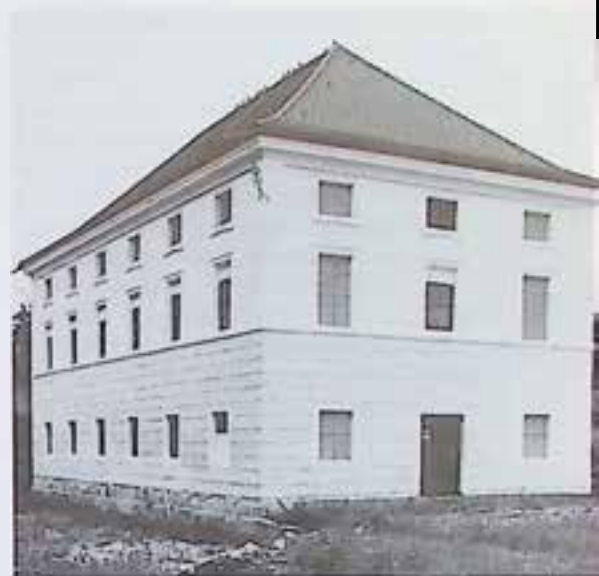
Aurolzmünster, Schloß, Marstall, nach Außeninstandsetzung. – Foto: BDA (Oberer)
