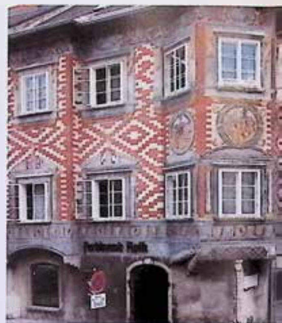
Wels, Stadtplatz 24, Fassadenmalerei nach Restaurierung. – Foto: G. Duschek
