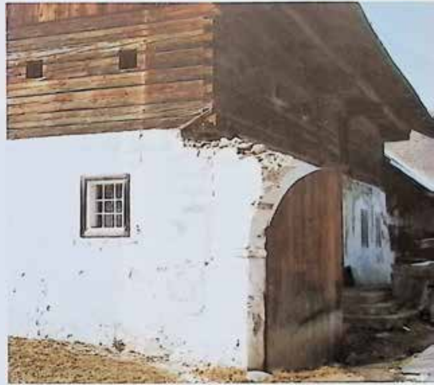
Kombination von gemauertem Erdgeschoß mit Pseudograffiti und Obergeschoß in Blockbauweise, Altmünster.
