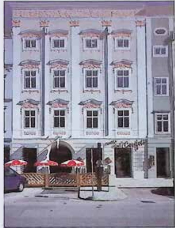
Wels, Stadtplatz 3, Spätbarockfassade nach Restaurierung. – Foto: W. Ebenhofer
