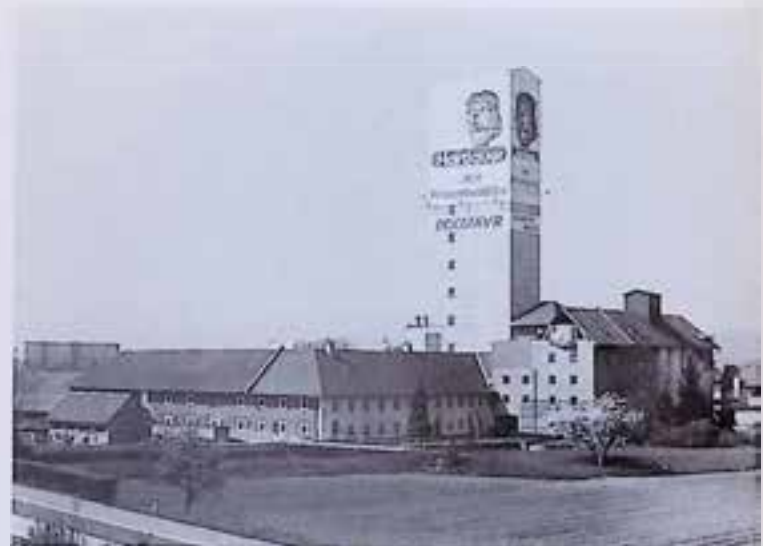
Kampmühle am Ipfbach, derzeitiger Zustand mit jüngeren und jüngsten Umbauten und Erweiterungen.
