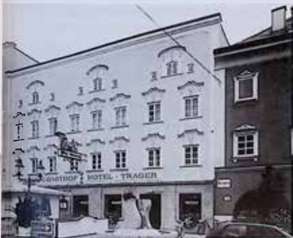
Ried im Innkreis, Roßmarkt 27, nach Fassadeninstandsetzung. – Foto: BDA (Oberer)
