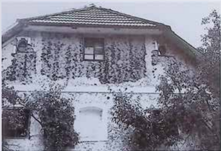
Mit Lehm verputzte Flechtwand im Giebel, Laussa.
