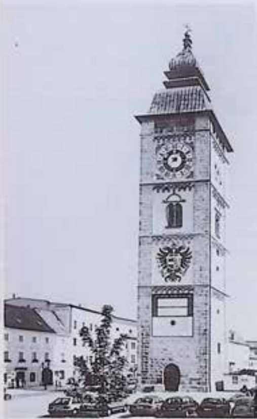
Enns, Stadtturm auf dem Hauptplatz, nach Instandsetzung. – Foto: BDA (Oberer)
