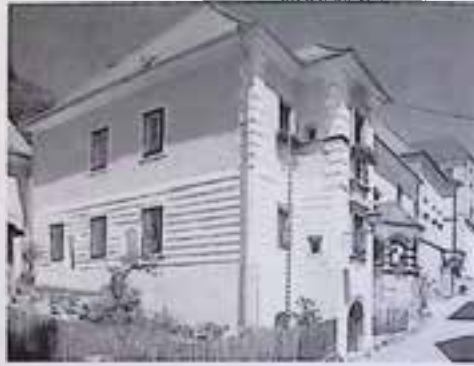
Kremsmünster, Herrengasse 7, nach Instandsetzung. Foto: BDA (Oberer)
