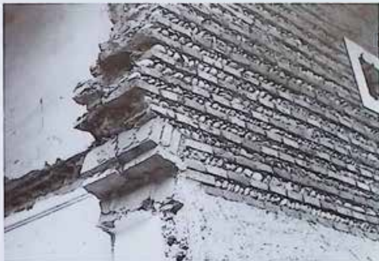
Streifenmauerwerk. Abwechselnd sind gebrannte Ziegel und Flußkiesel vermauert, Losensteinleiten.
