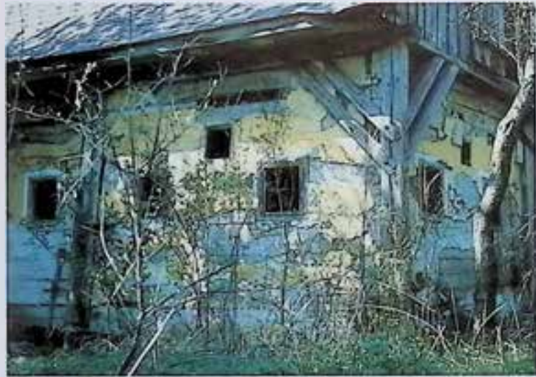
Altartige Kombination von Ständerbau und Blockbau, Schlögen.
