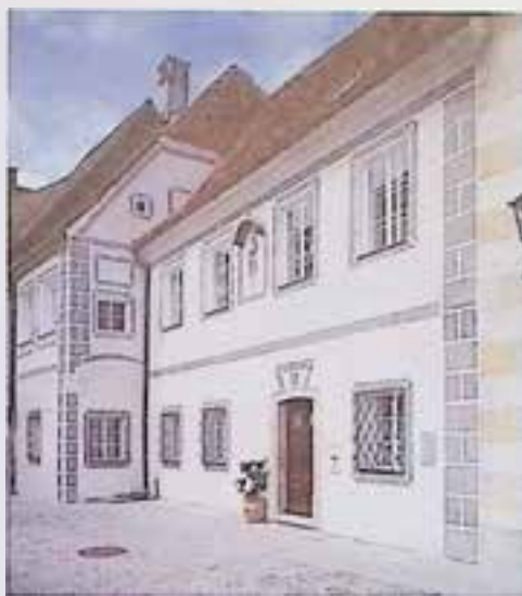
Steyr, Berggasse 38, nach Freilegung und Restaurierung der Frühbarockfassade Foto: W. Ebenhofer
