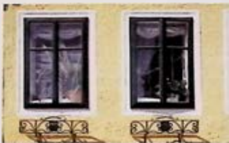
Neufelden, Markt 24, Fassadendetail nach Restaurierung. – Foto: BDA (Oberer)
