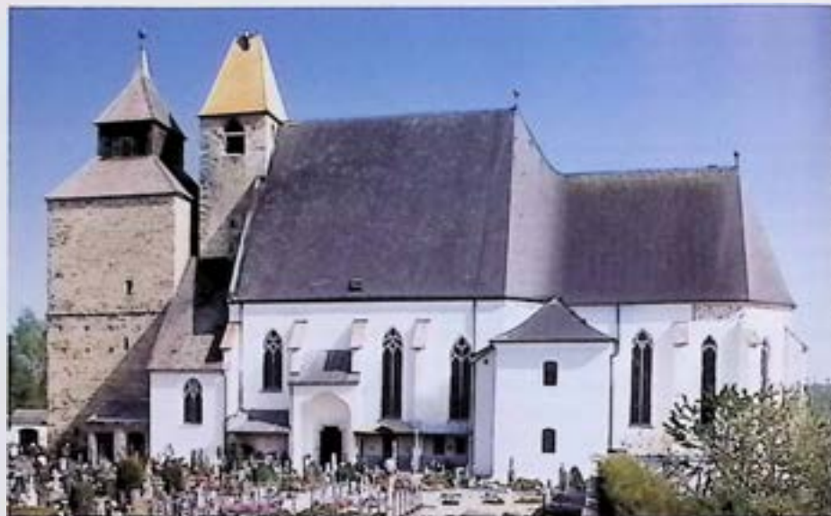
Schöndorf, Filialkirche, nach Außenrestaurierung. – Foto: BDA (Oberer)
