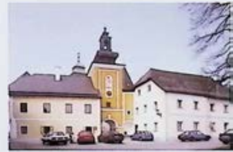
Pfarrkirchen im Mühlkreis, Alte Schule nach Instandsetzung im Ensemble des Kirchenplatzes. – Foto: BDA (Oberer)
