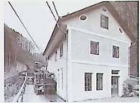
Trattenbach, Hammerstraße 45, Rameishammer. - Foto: BDA (Oberer)
