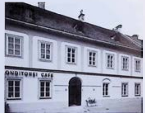
Steyr, Wieserfeldplatz 6, nach Instandsetzung. – Foto: BDA (Oberer)
