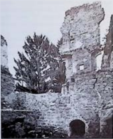
Prandegg, Ruine, ehemaliger Palas, nach Sicherung. – Foto: BDA (Oberer)
