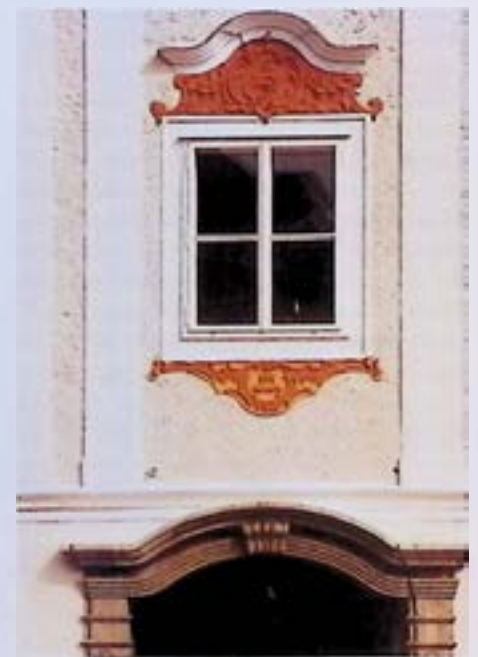
Lambach, Marktplatz 12, Fassadendetail nach Restaurierung. – Foto: Simböck
