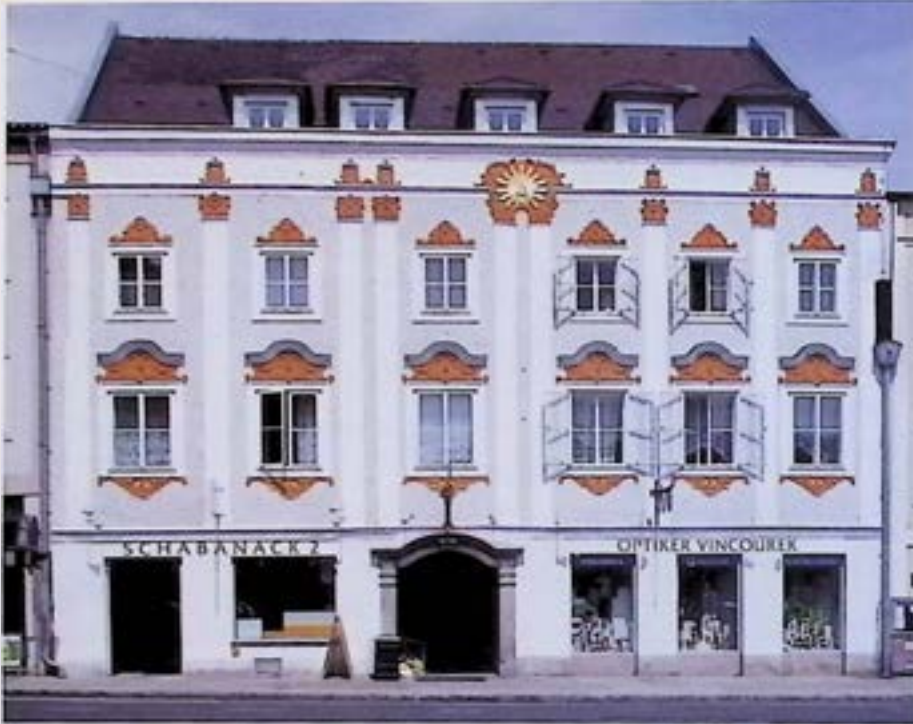
Lambach, Marktplatz 12, nach Fassadenrestaurierung. – Foto: BDA (Oberer)
