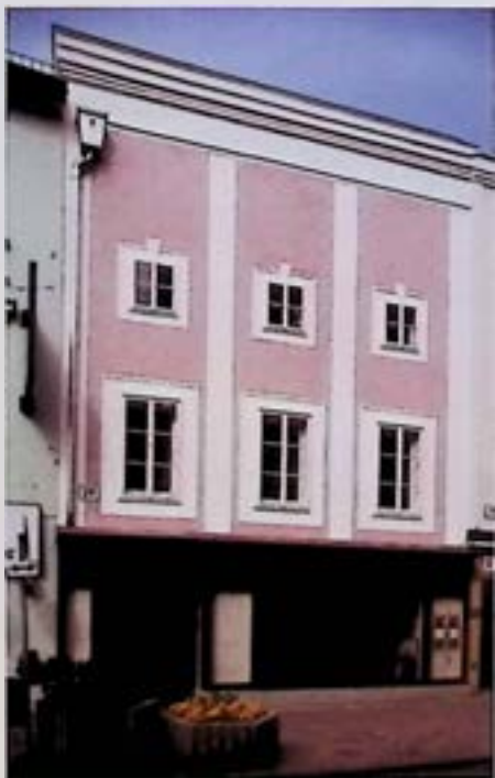
Wels, Pfarrgasse 10, nach Fassadenrestaurierung. – Foto: BDA (Oberer)
