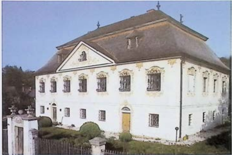
Krensmünster, Kirchberg 1, nach Holzschindeldeckung. – Foto: BDA (Oberer)
