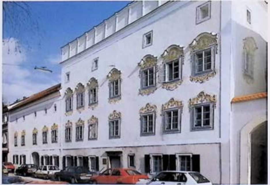
Grieskirchen, Prechtlerstraße 18, nach Fassadenrestaurierung. – Foto: BDA (Oberer)
