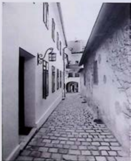
Steyr, Kirchengasse 12, Innenhof nach Instandsetzung. – Foto: BDA (Oberer)
