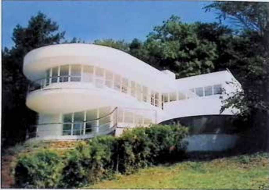
Puchenau, Kaindlweg 12, Villa Rosenbauer, nach Instandsetzung. – Foto: R. Mittermaier.
