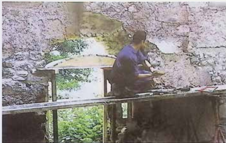
Prandegg, Ruine, Sicherheits- und Restaurierungsarbeiten. – Foto: Burgenverein Prandegg.
