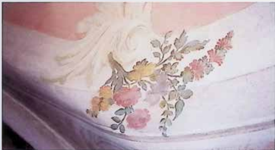
Grossraming, Pfarrkirche, Deckenmalerei im Chor von 1759, nach Restaurierung. – Foto: BDA.
