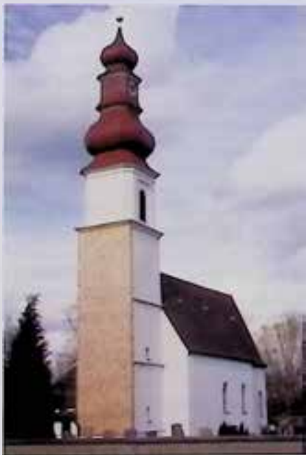
Jeging, Pfarrkirche, nach Außeninstandsetzung. – Foto: BDA.
