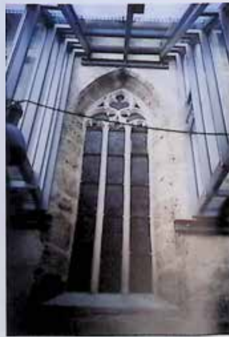
Kirchham, Pfarrkirche, Verbindungsbau von F. Kurrent. – Foto: BDA.
