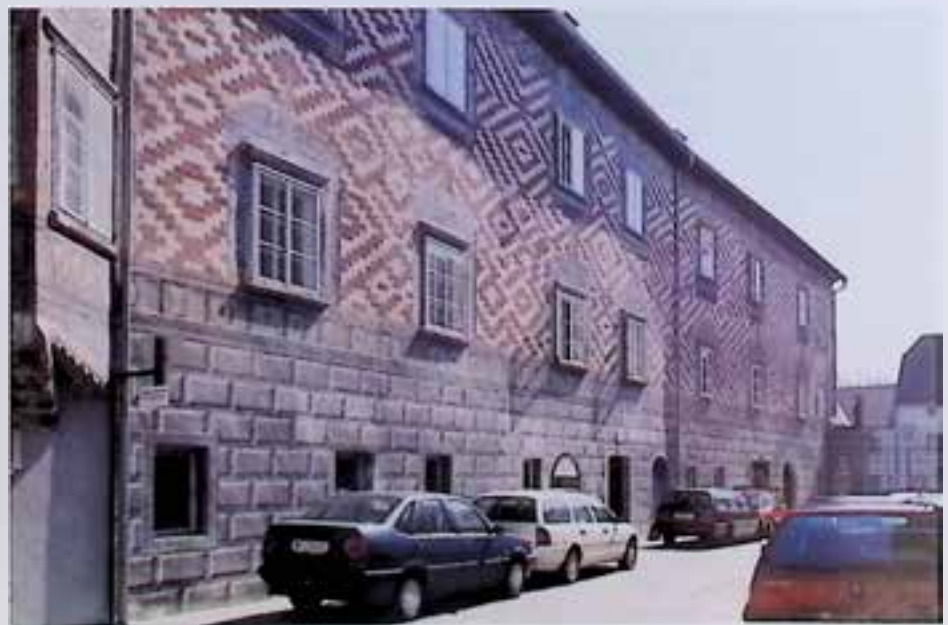
Wels, Stadtplatz 24, nach Rekonstruktion der Sockelmalerei. – Foto: BDA.
