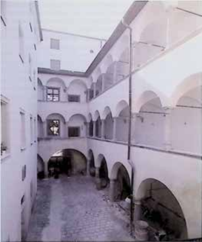
Wels, Stadtplatz 52, Arkadenhof von 1590 während Restaurierung. – Foto: BDA.
