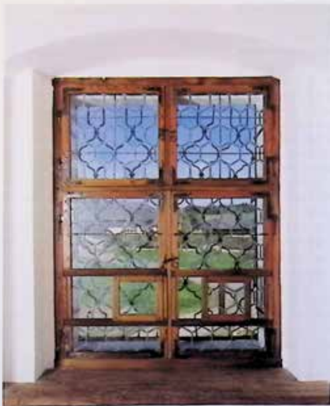
Kremsmünster, Regau 9, barockes Originalfenster nach Restaurierung. – Foto: BDA.
