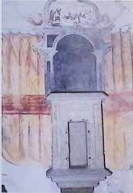
Pulgarn, ehem. Klosterkirche, Sakramentshäuschen mit Wandmalerei, nach Freilegung. – Foto: H. Leitner.
