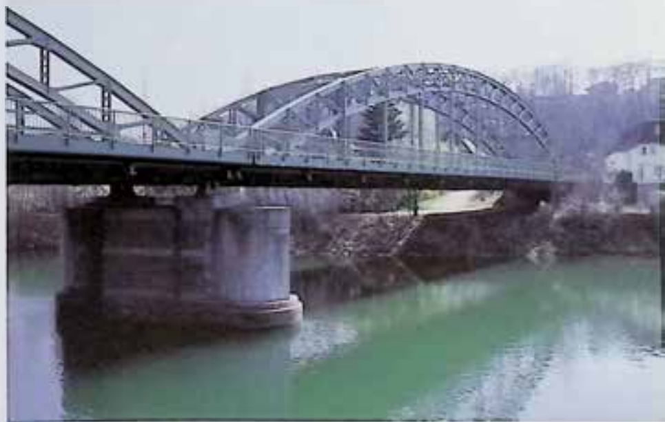
Wels, Traunbrücke, nach Instandsetzung und Adaptierung. – Foto: BDA.
