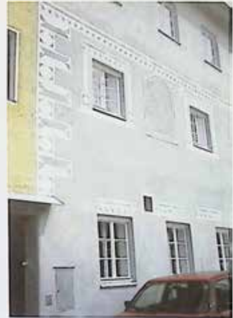
Steyr, Fabrikstraße 26, Detail der Sgraffitodekoration nach Freilegung. – Foto: BDA.
