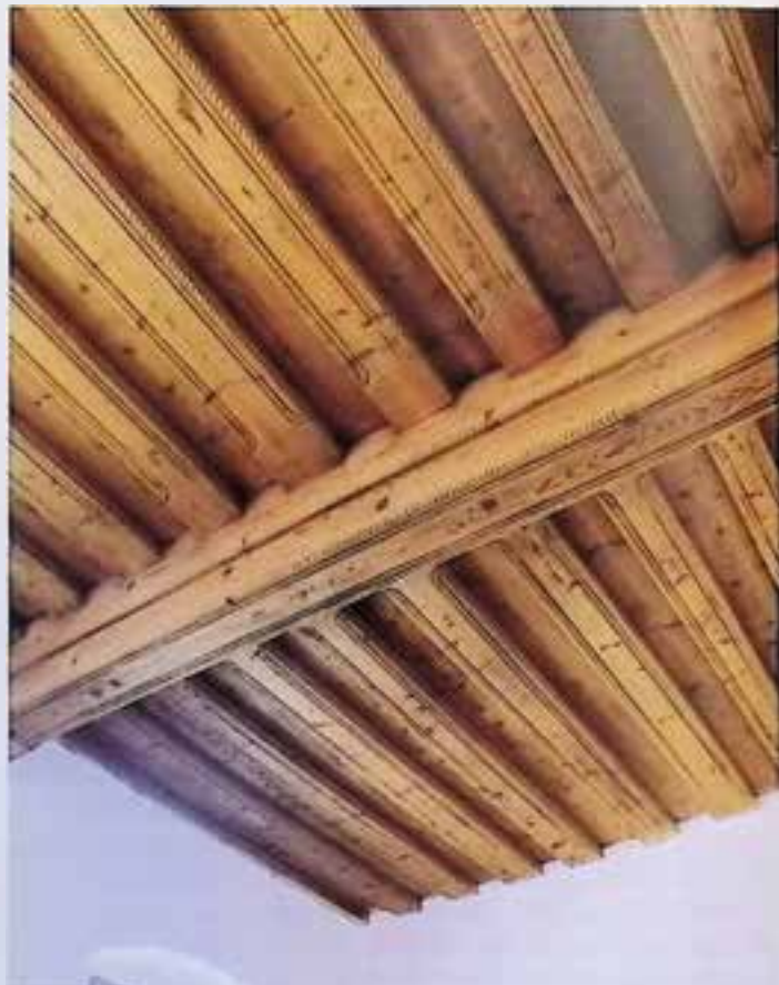
Kremsmünster, Regau 9, Balkendecke nach Restaurierung. – Foto: BDA.
