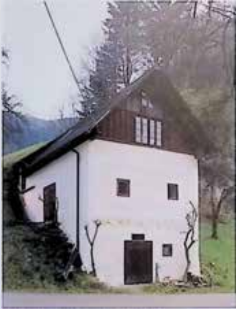
Losenstein, Stiedelsbach 49, Mostkeller, nach Restaurierung. – Foto: BDA.
