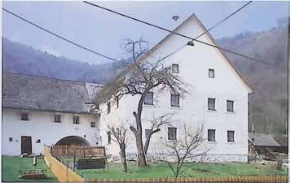
Ternberg, Trattenbachstraße 15. – Foto: BDA.
