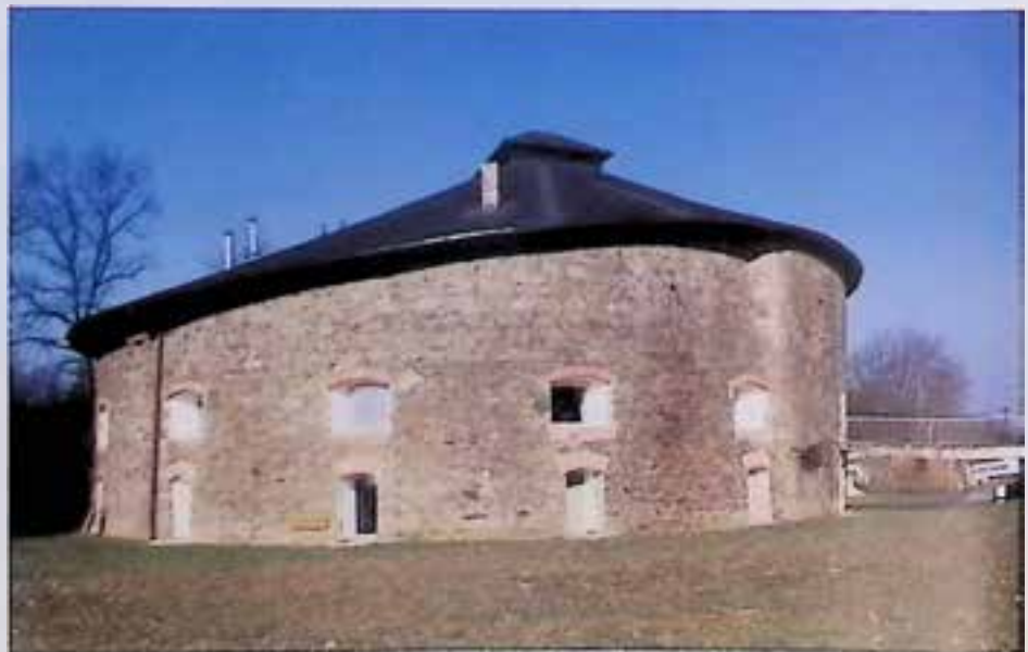
Leonding, Buchberg 2, Turm IX., nach Instandsetzung und Adaptierung. – Foto: BDA.
