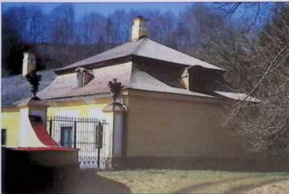
Neuwartenburg, Schloß, Eckpavillon, Holzschindeldeckung. – Foto: BDA.
