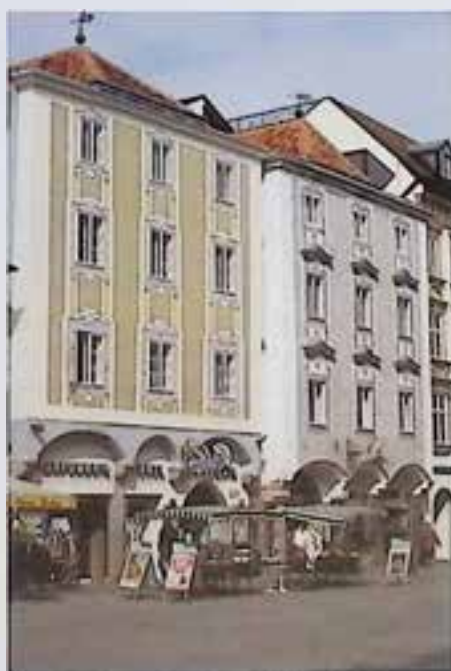
Steyr, Stadtplatz 8-10, nach Fassadenrestaurierung. – Foto: BDA.
