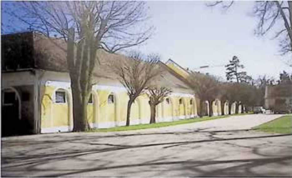
Stadl-Paura, Stallamtsweg 1-7, ehem. Hengstendepot, Sanierungsbeginn. – Foto: BDA.
