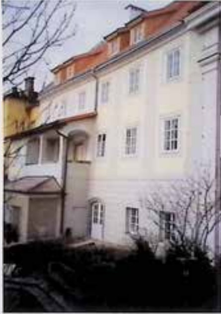
Steyr, Berggasse 14, nach Instandsetzung. – Foto: BDA.
