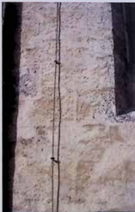
Kirchham, Pfarrkirche, Detail der Südseite nach Putzrestaurierung. – Foto: BDA.
