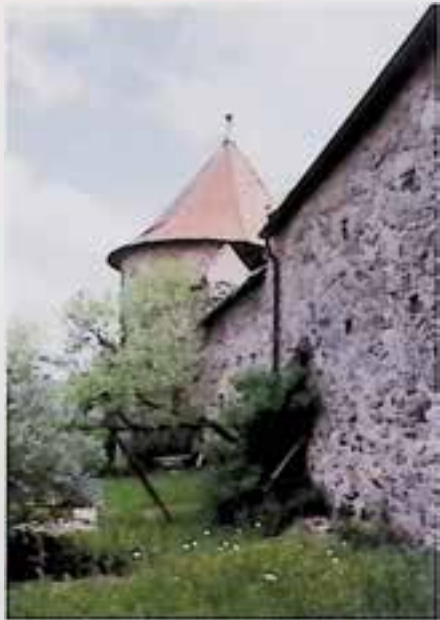
Haslach, Ringmauer, Nordwestecke. – Foto: BDA.
