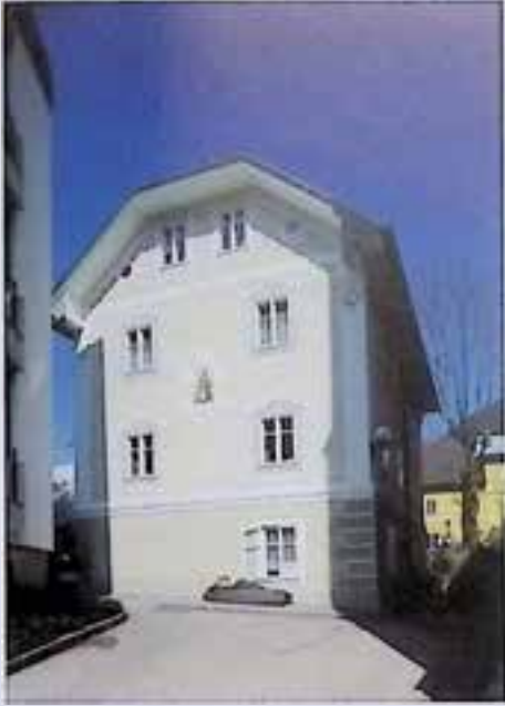
Bad Ischl, Kirchengasse 3, nach Instandsetzung. – Foto: BDA.
