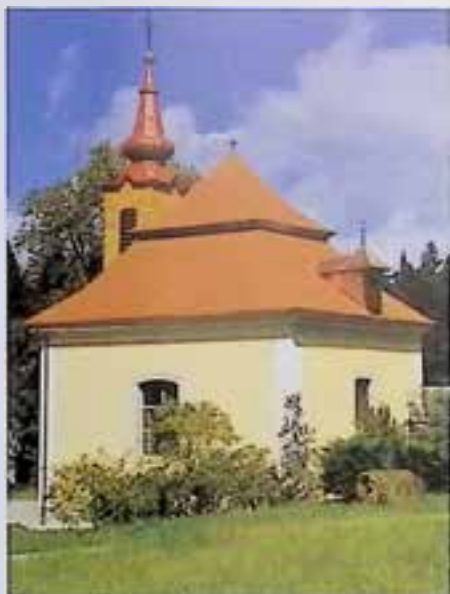
St. Oswald bei Freistadt, Maria Bründl Kapelle, nach Außeninstandsetzung. – Foto: J. Friesenecker.
