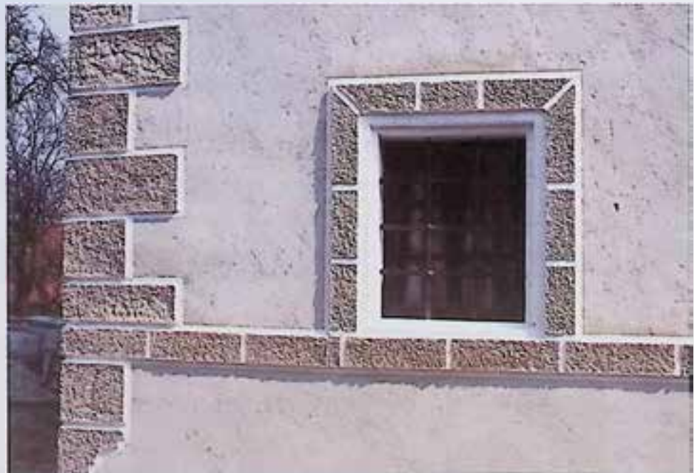
Kremsmünster, Regau 9, Putzfassade um 1640 nach Restaurierung. – Foto: BDA.
