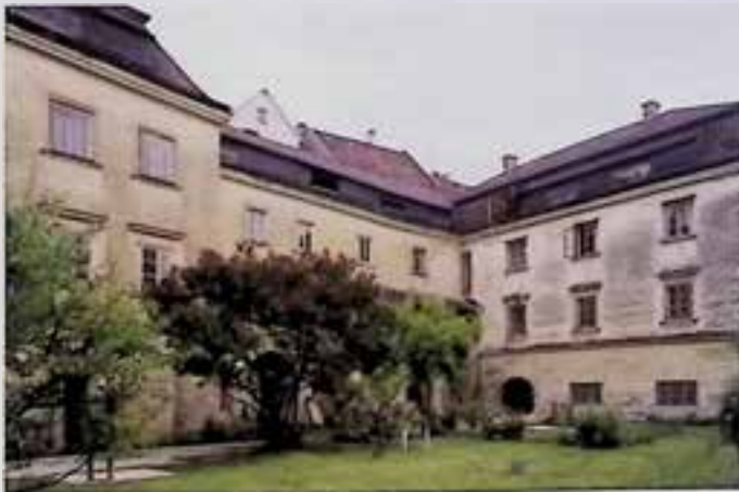
Steyr, Fabrikstraße 3, ehem. Ledererhaus, vor Instandsetzung. – Foto: BDA.
