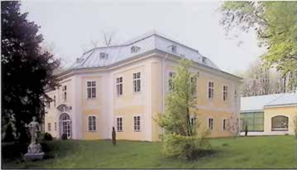
Linz, Bergschlüssel, Außenansicht nach Instandsetzung und Adaptierung. – Foto: BDA.
