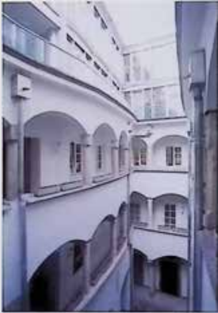
Linz, Hauptplatz 13 / Hofgasse 1, Arkadenhof nach Instandsetzung und Adaptierung. – Foto: BDA.
