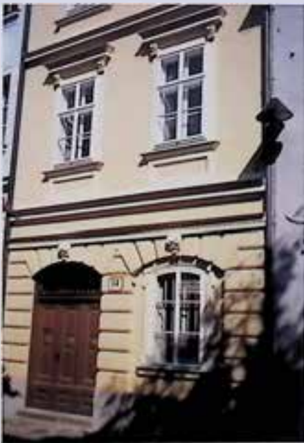
Wels, Johannesgasse 14, nach Fassadeninstandsetzung. – Foto: BDA.
