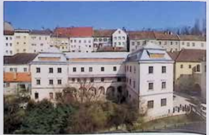
Steyr, Fabrikstraße 3, ehem. Ledererhaus, nach Instandsetzung. – Foto: BDA.
