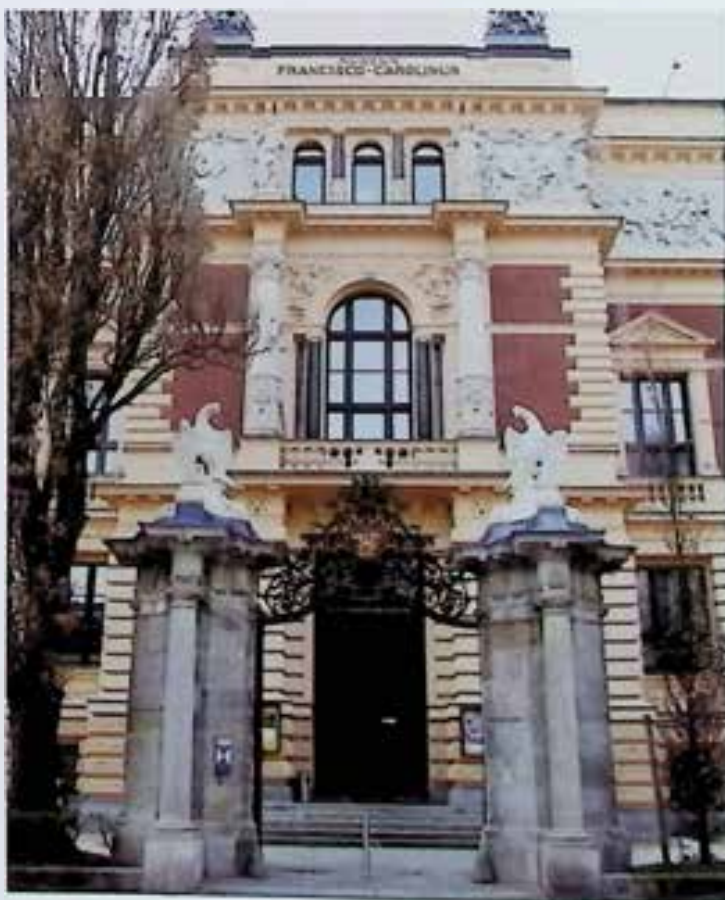
Abb. 5: Das ehem. Brückentor steht heute vor dem OÖ. Landesmuseum
