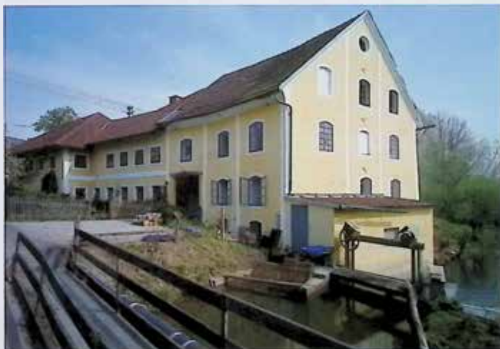
Neuhofen an der Krems, Obermühle, Denkmalschutz 2008
