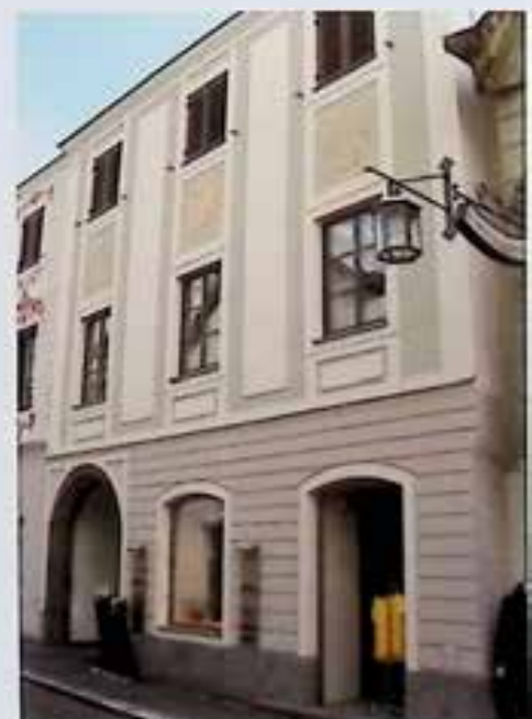
Steyr, Grünmarkt 21, nach Fassadenrestaurierung, Foto: H.-J. Kaiser
