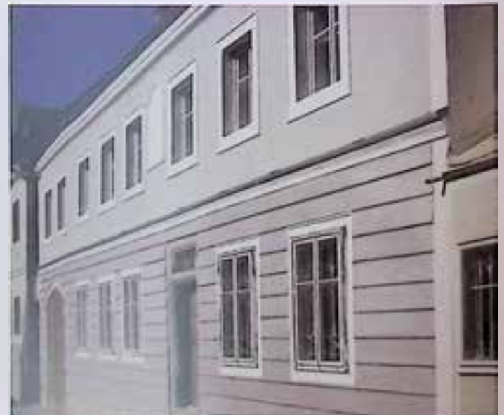
Steyr, Wieserfeldplatz 42, Sanierung der biedermeierlichen Fassade, Foto: H.-J. Kaiser
