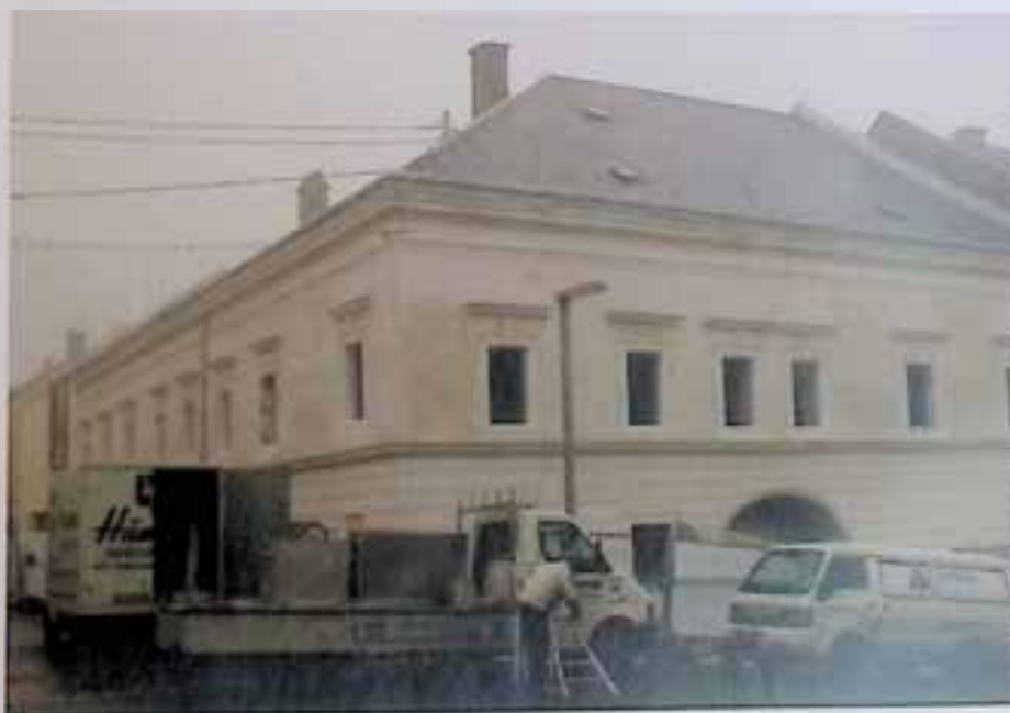
Ottensheim, Marktplatz 6/7, Neues Rathaus, während des Umbaus
