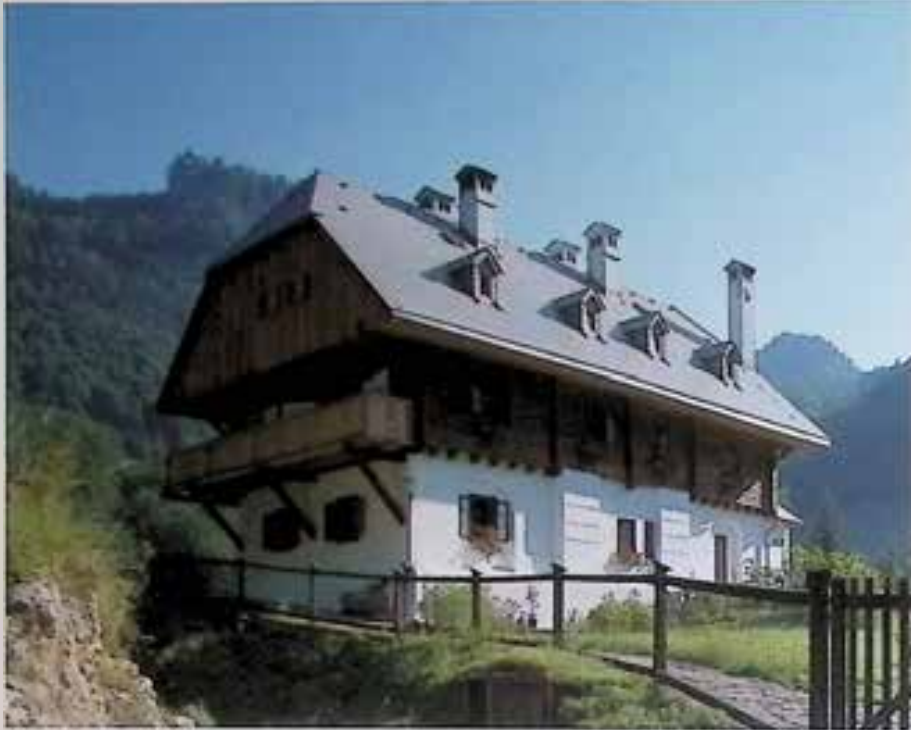
Rosenau am Hengstpass, Bodinggraben, Forsthaus, nach Generalsanierung
