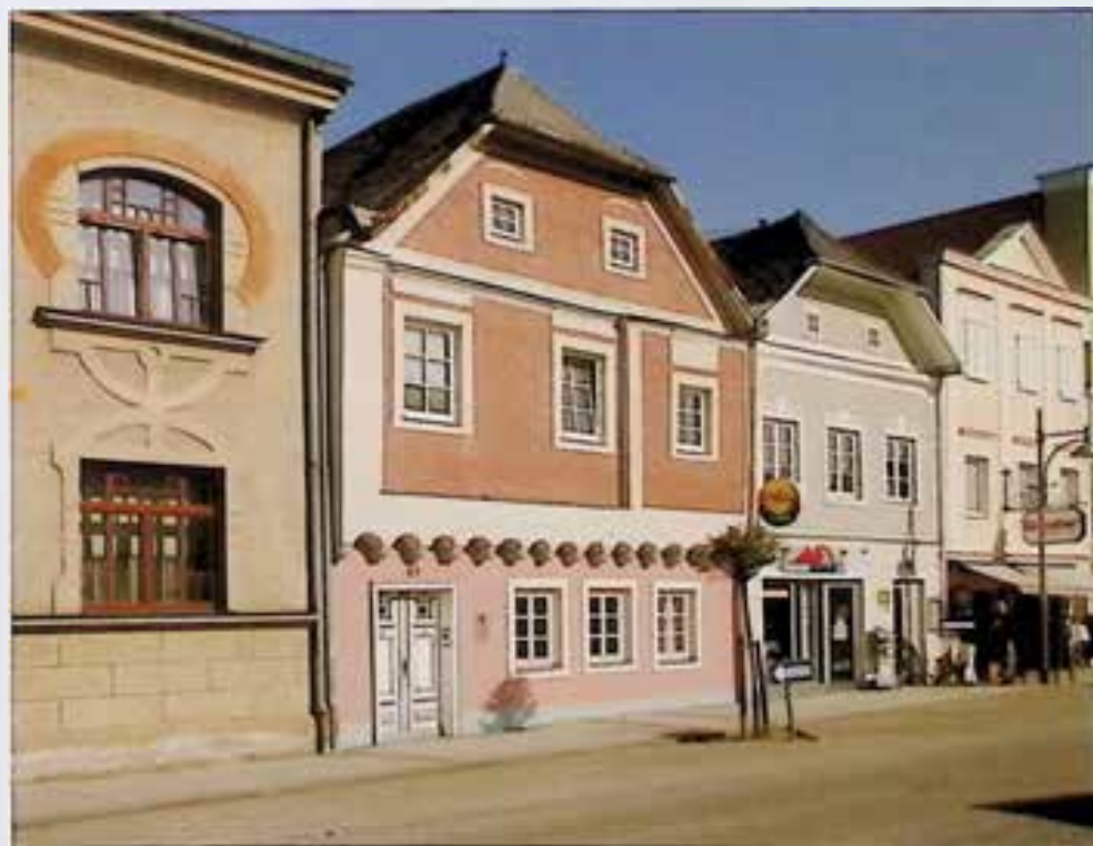
Eferding, Stadtplatz 6, Fensterrückbau im EG
