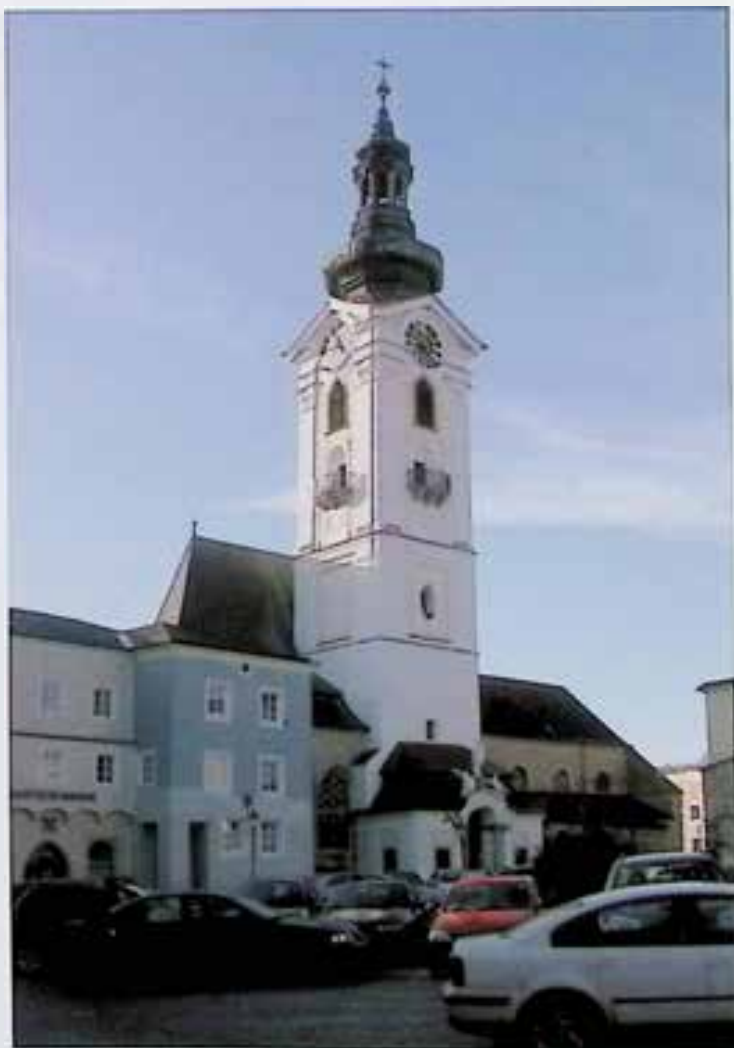
Freistadt, Turm der Stadtpfarrkirche nach Restaurierung
