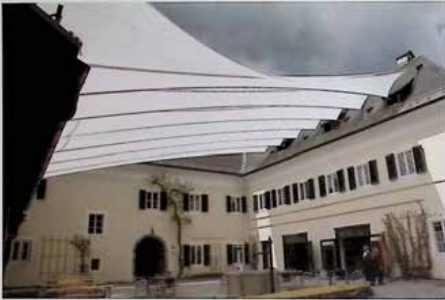
Bad Goisern, Schloss Neuwildenstein, Hofüberdachung
