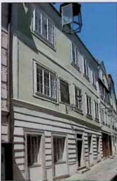
Steyr, Gleinker Gasse 3, nach Sanierung, Foto: H.-J. Kaiser
