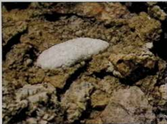
Abb. 10: Teilgebrannter Kalk-Flusskiesel im Kernmörtel des Bergfrieds
