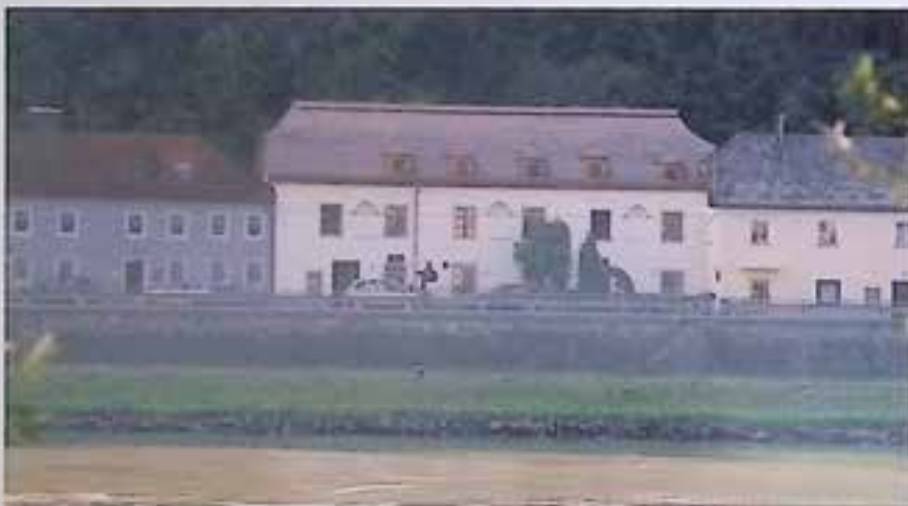
Linz, Obere Donaulände 51, Cinematograph, Wiederherstellung der Holzschindeldeckung
