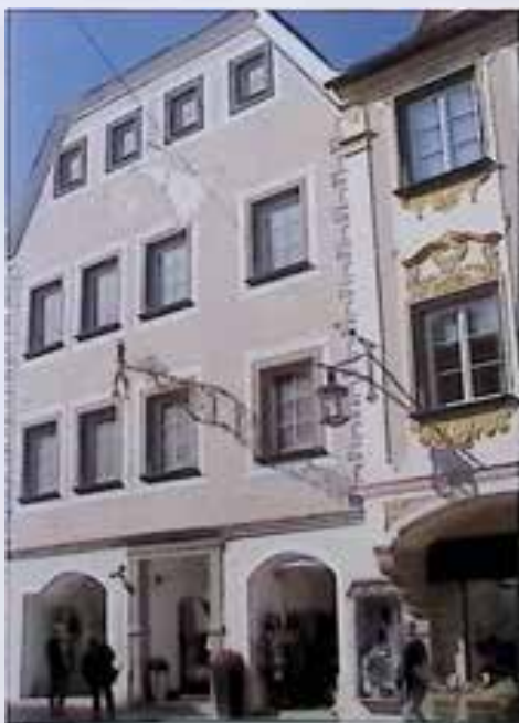
Steyr, Grünmarkt 10, nach Fassadenrestaurierung, Foto: H.-J. Kaiser
