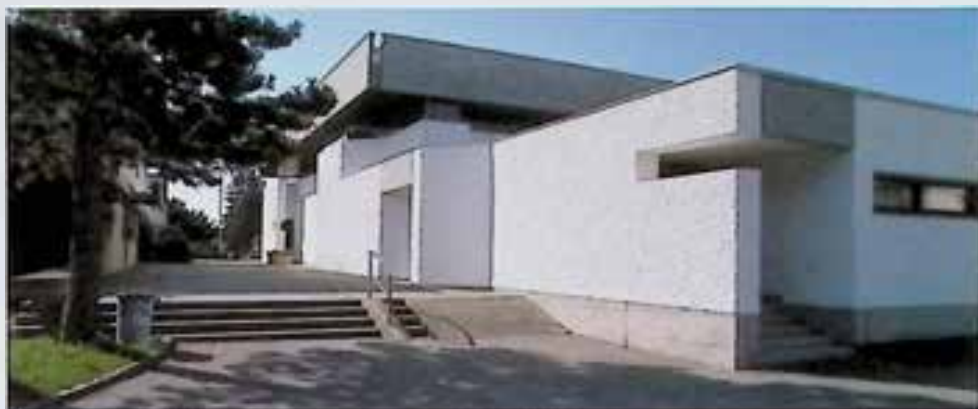
Pasching, Pfarrkirche Langholzfeld, Betonsanierung
