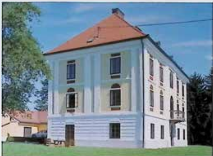
Sierning, Pfarrhof, nach Generalsanierung
