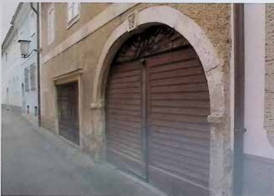
Ottensheim, Lederergasse 4, Denkmalschutz 2008
