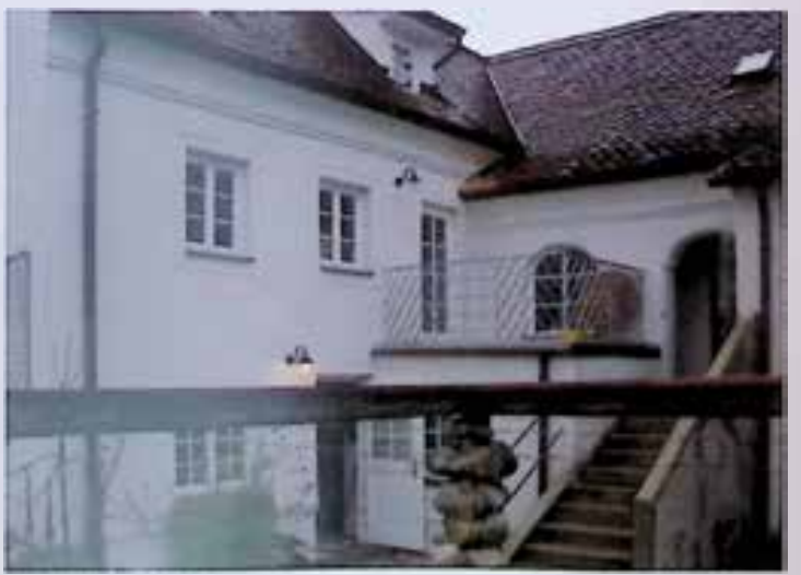
Steyr, Mittere Gasse 13, Hof nach Sanierung, Foto: H.-J. Kaiser
