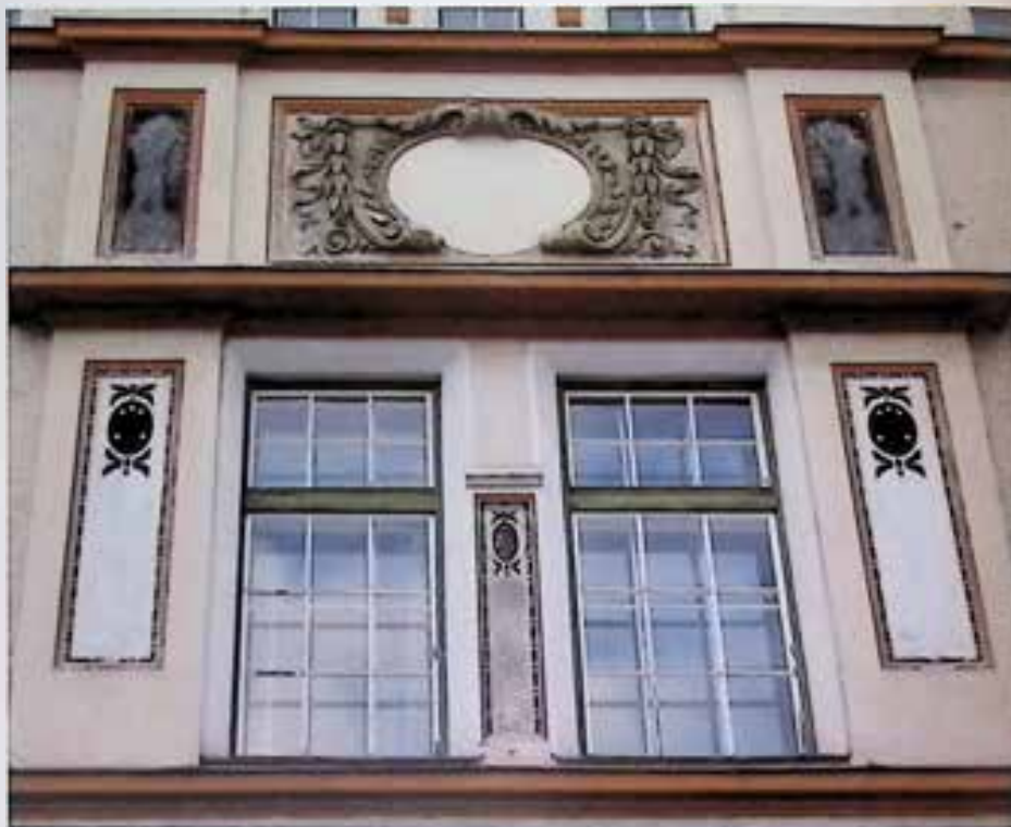
Linz, Fabrikstraße 26-28, Dorotheum, Fassadendetail, Denkmalschutz 2009
