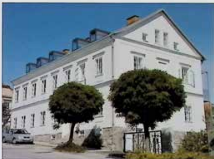
Steyr, Direktionsstraße 6, Fassadengestaltung nach Originalplänen aus 1891, Foto: H.-J. Kaiser
