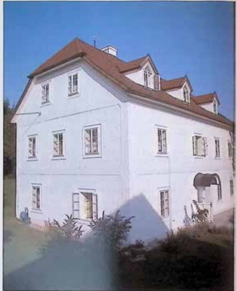
Holzhausen, Pfarrhof, nach Restaurierung und Dachgeschoßausbau
