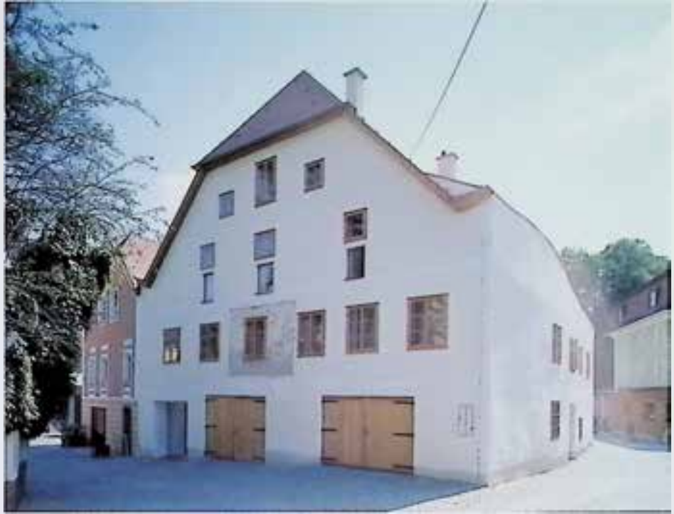
Schärding, Kurhausstr. 3, nach Umbau, Fassade mit Sgraffito-Dekor
