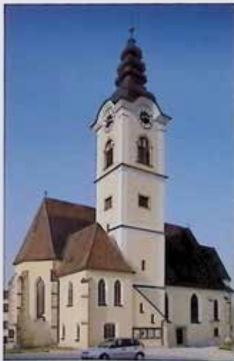
St. Marienkirchen an der Polsenz, Pfarrkirche, Zustand vor Restaurierung
