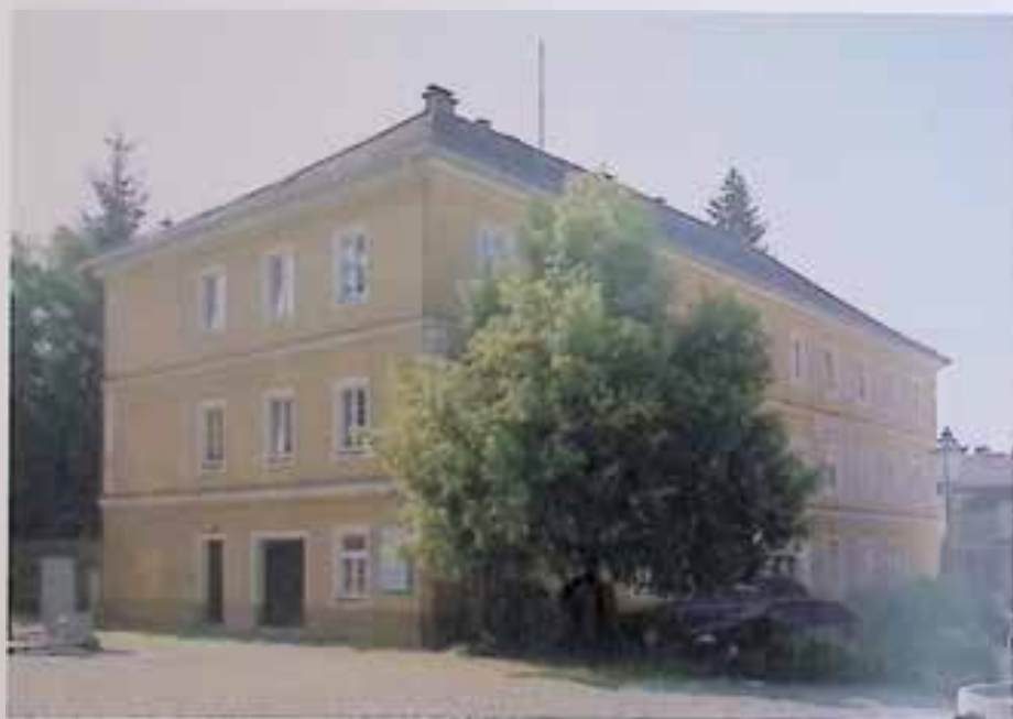
Peuerbach, Kirchenplatz 16 + 18, Alte Volksschule, Denkmalschutz 2008
