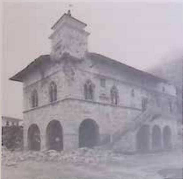
Friaul, Venzone, Rathaus nach Erdbeben
