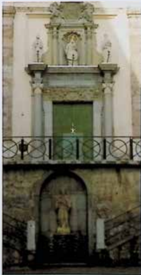
Steyr, Vorstadtpfarrkirche St. Michael, nach Portalrestaurierung
