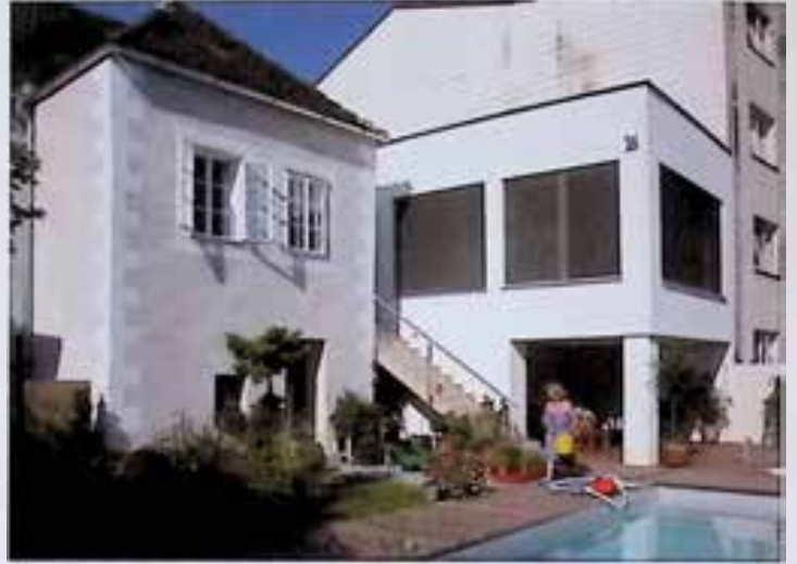
Steyr, Mittere Gasse 11, Hof nach Sanierung, Foto: H.-J. Kaiser
