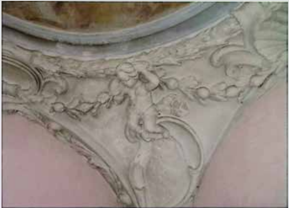
Timelkam, Oberthalheim 21, Schleisshaus, Denkmalschutz 2008
