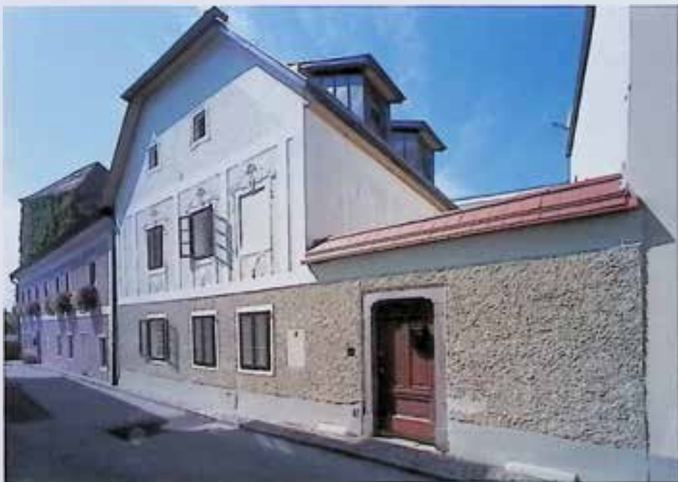
Enns, Pfarrgasse 27, Wiederherstellung von Holzkastenfenstern
