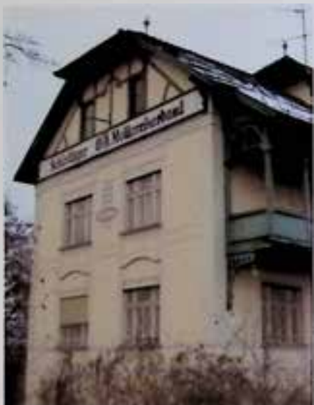
Schärding, Bahnhofstraße 57, Denkmalschutz 2009
