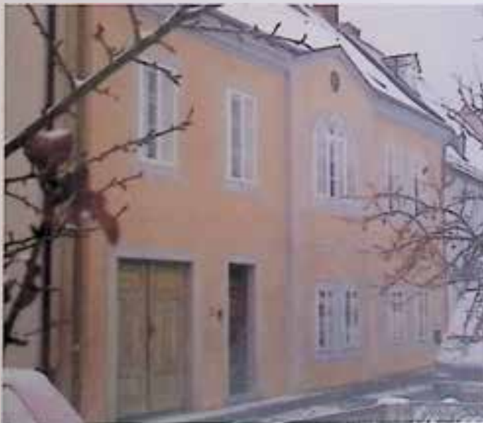
Steyr, Wieserfeldplatz 19, nach Restaurierung, Foto: H.-J. Kaiser
