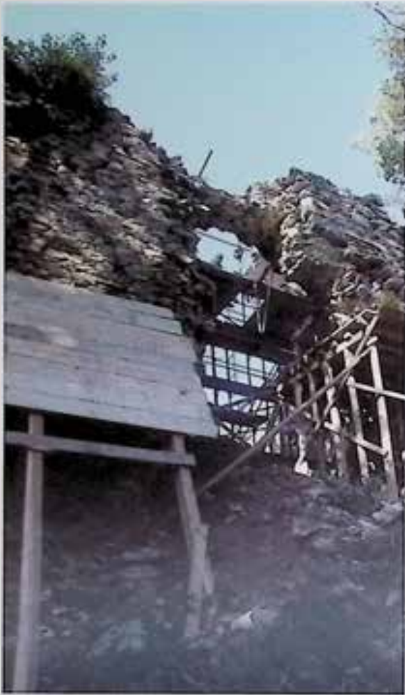
Hofkirchen i. M., Burgruine Falkenstein, statische Sanierung des Hauptbogens
