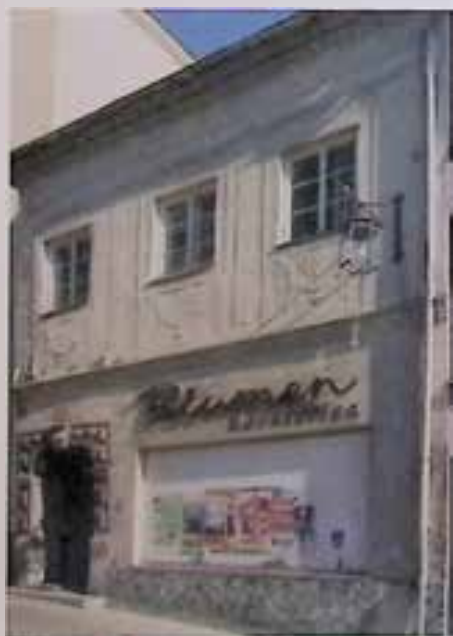
Steyr, Gleinker Gasse 28, vor Sanierung, Foto: H.-J. Kaiser
