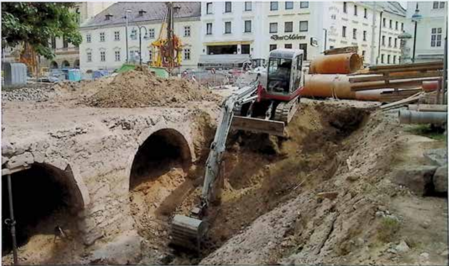
Abb. 1: Erste Freilegungsarbeiten nach Auffindung der Brücke
