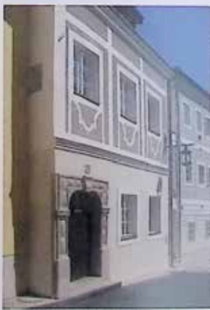
Steyr, Gleinker Gasse 28, nach Sanierung, Foto: H.-J. Kaiser
