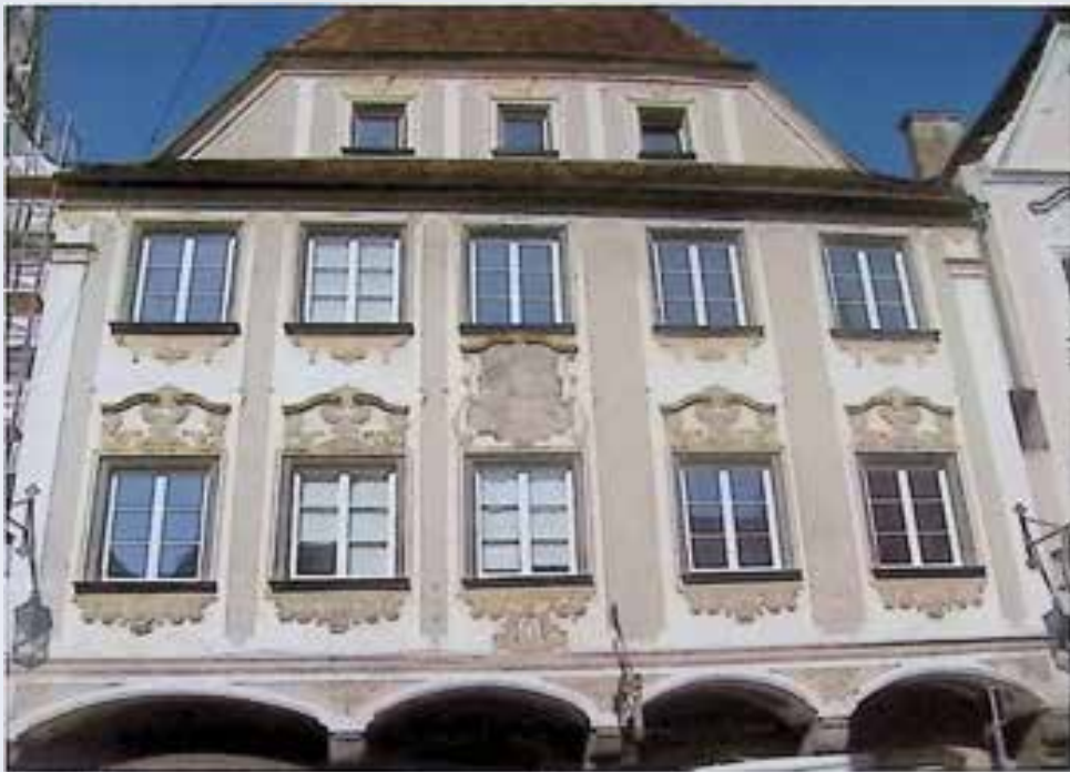
Steyr, Grünmarkt 8, nach Fassadenrestaurierung, Foto: H.-J. Kaiser
