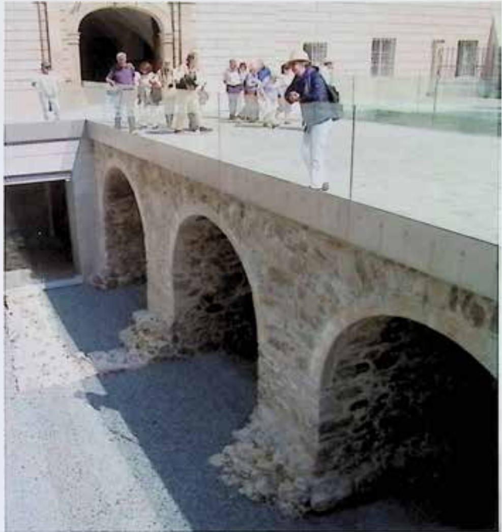
Abb. 7: Die Brücke nach der Fertigstellung
