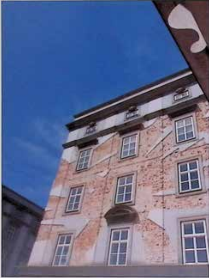
Linz, Brückenkopfgebäude Ost, Fluchtwege an der Fassade, Kunstprojekt, Foto: Bettina Neubauer
