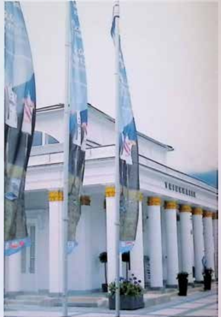
Bad Ischl, Trinkhalle, Foto: Stadtgemeinde Bad Ischl
