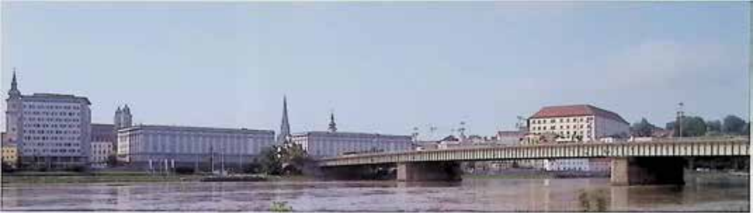
Linz, Brückenkopfgebäude und Nibelungenbrücke, Blick von Urfahr
