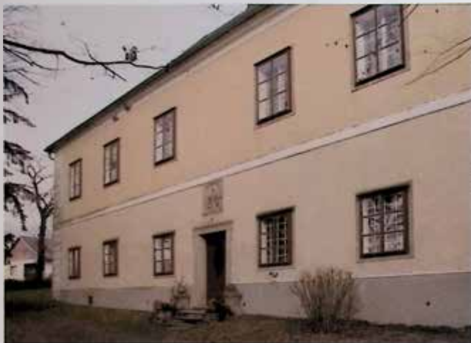
Windhaag bei Perg, Forsthausstraße 1/ Pfliegerstraße 2, ehem. Taverne, Denkmalschutz 2008
