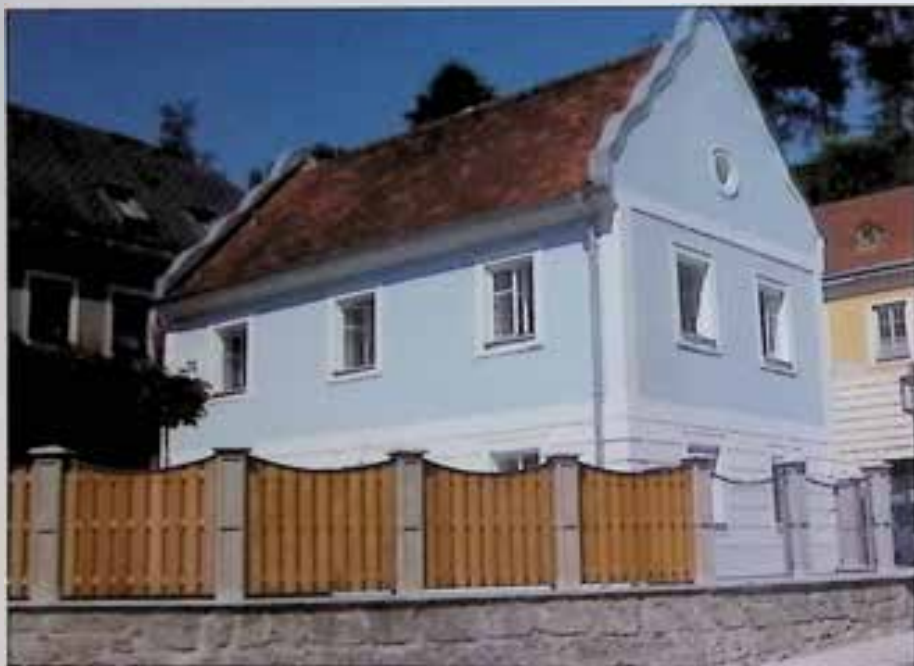
Steyr, Gleinker Gasse 27, nach Sanierung, Foto: H.-J. Kaiser
