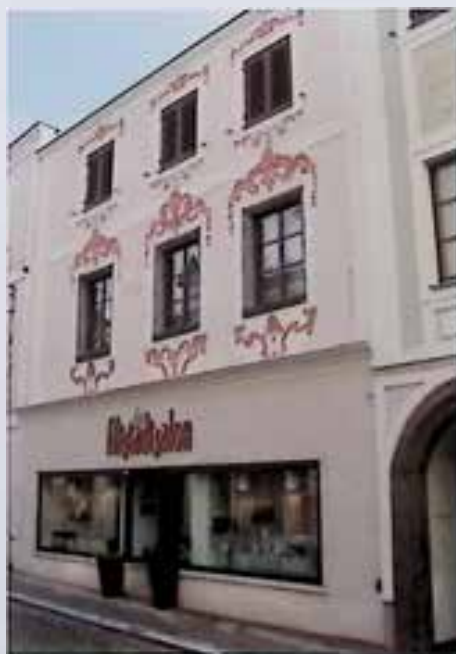
Steyr, Grünmarkt 19, nach Fassadenrestaurierung, Foto: H.-J. Kaiser
