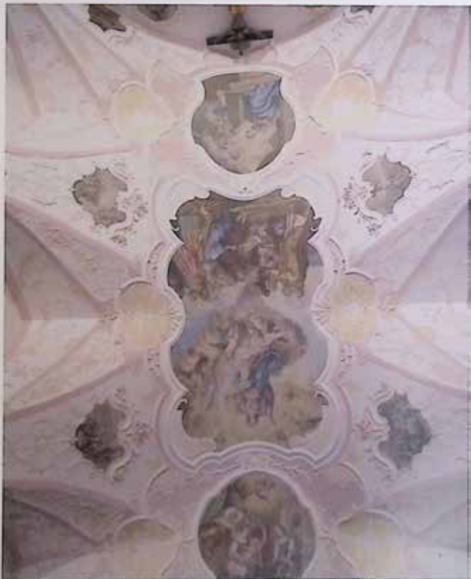
Mühlheim, Pfarrkirche, Wiederherstellung der spätbarocken Farbgebung
