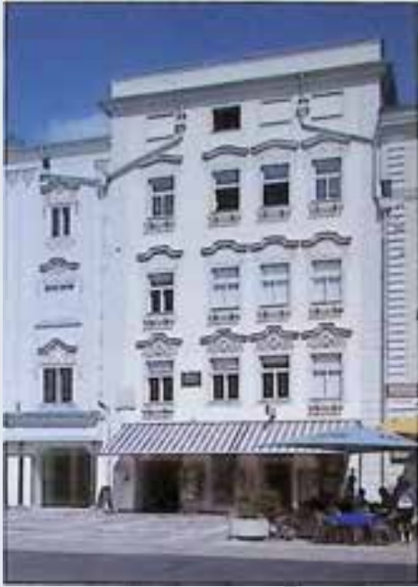
Wels, Stadtplatz 34, Fassade mit Pfostenstockfenstern
