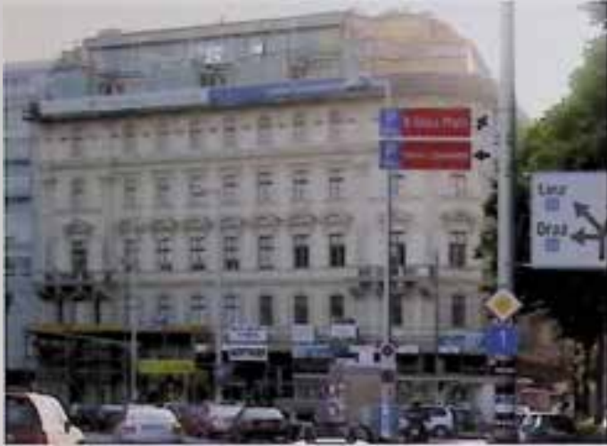
Wien, Karlsplatz, Dachausbau in der Kernzone des Welterbes
