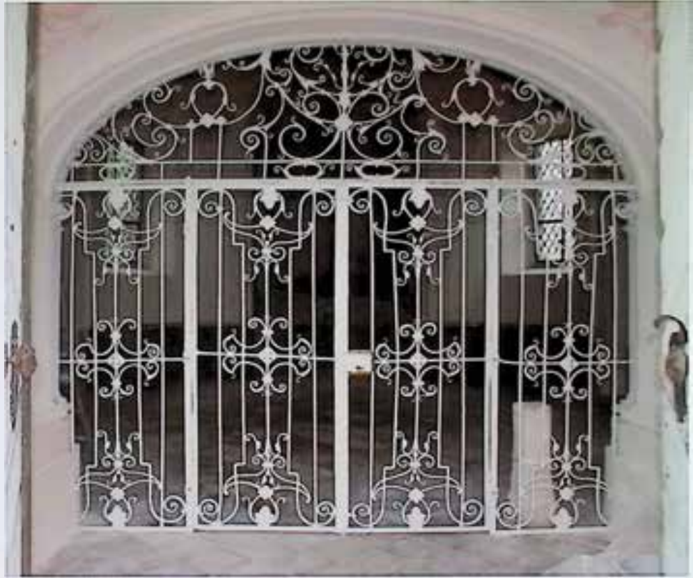
Kremsmünster, Kalvarienbergkirche, Detail des Abschlussgitters nach Anstrich mit Bleiweiß in Leinöl, Foto: Miklin-Kniefacz
