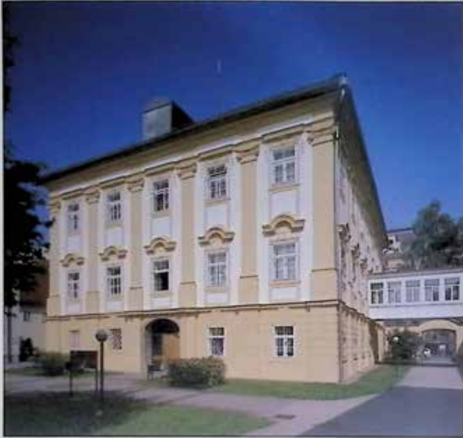
Wels, Herrengasse 8, Palais Tilly nach Fassadensanierung
