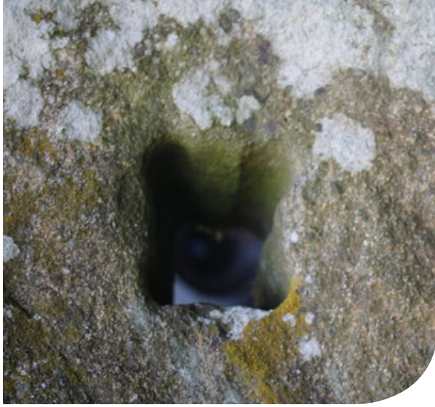
BEIM PÖTZLBAUER IN VICHTENSTEIN IST AN EINER GATTERSÄULE NOCH GUT ERKENNBAR, WIE DAS VIERECKIGE LOCH HERGESTELLT WURDE. AN DEN VIER ECKPUNKTEN WURDEN KLEINERE LÖCHER GEOHRT UND DANN DIE ÖFFNUNG DURCHGESCHLAGEN.
